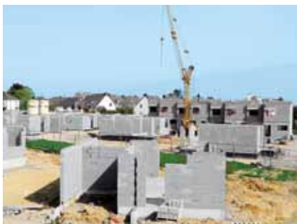
Le programme "Perceval" en cours de construction.
